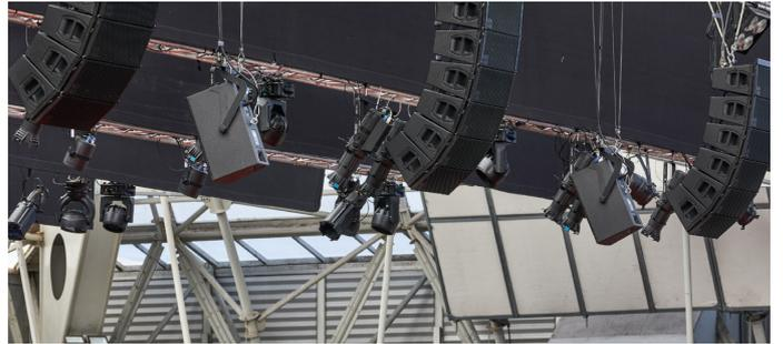
Acoustic shell의 Y10P 라우드 스피커와 프론트 트러스의 Y8/Y12 메인 시스템
